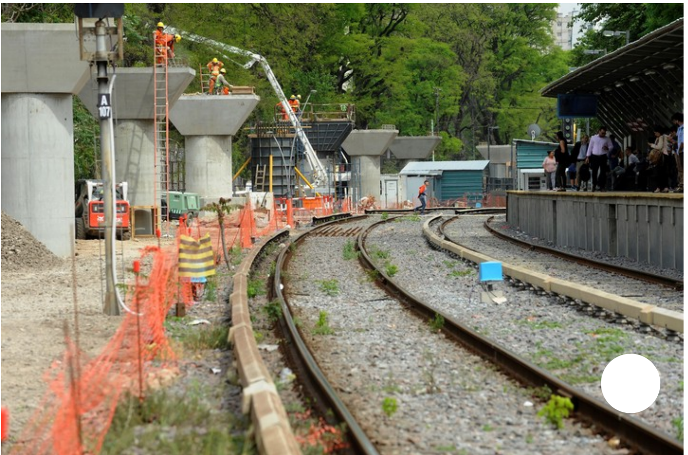
El viaducto para elevar el tren Mitre avanza de Belgrano a Núñez. Fotos Alfredo Martínez
